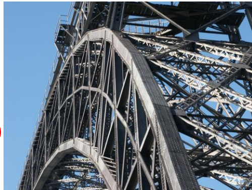
Coupe de l'arc au droit d'un montant
